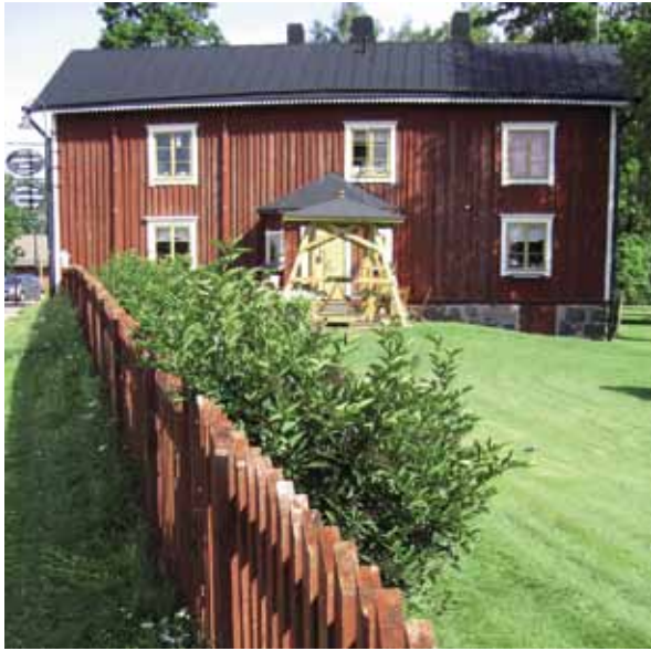
Aita suojaa piha-aluetta ulkopuolisilta kulkijoilta ja osoittaa alueen rajaa. Kuva: YHA Kuvapankki / Pirjo Ferin.
