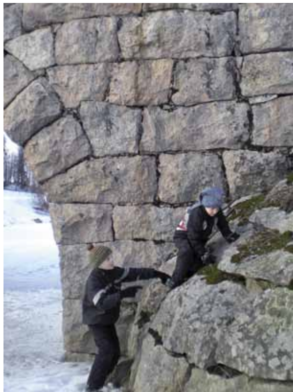
Haittaa aiheuttamattomia geokätköjä voi piilottaa ja etsiä jokamiehenoikeudella. Kuva: Suomen Latu.
